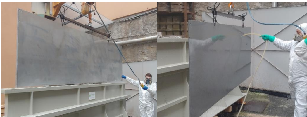
Fig. 3.4 – A sinistra il momento del sollevamento, e a destra il lavaggio della lastra. La vasca viene svuotata attraverso la sua valvola di scarico e l'acido esausto reinserito nelle taniche e stoccato in attesa di ritiro e smaltimento dalla ditta autorizzata.
