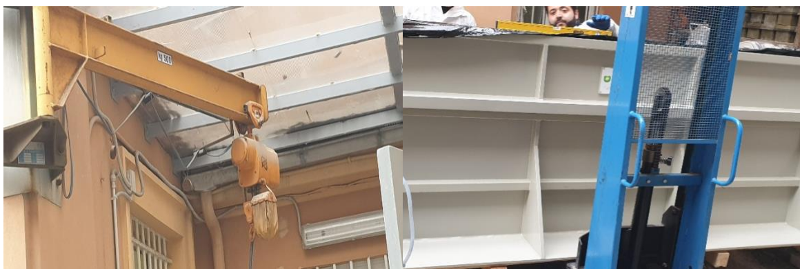
Fig. 3.3- A sinistra la gru utilizzata per il sollevamento della lastra, a destra l'utilizzo della livella e del carrello sollevatore per posizionare la vasca
