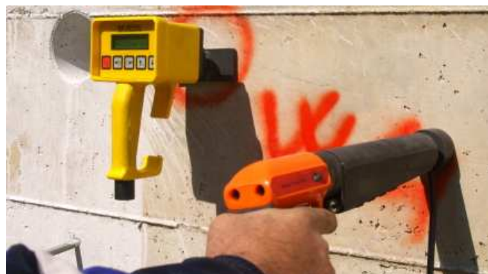
Figura 17. Metodo Windsor: a destra: infissione della sonda; a sinistra: misurazione della profondità di penetrazione
