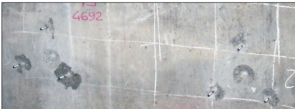
Figura 35. Dettaglio delle prove di pull out e delle prove con sonde Windsor .
