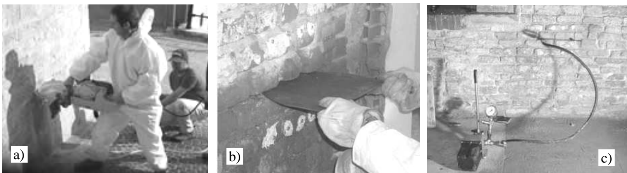
Figura 25. Martinetto piatto singolo: a) esecuzione del taglio; b) inserimento del martinetto piatto; c) aumento della pressione idraulica.
