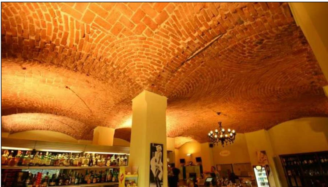
**Figura 37:** Struttura interna a pilastri, archi ribassati e volte ribassate a formazione di ampi spazi aperti.
