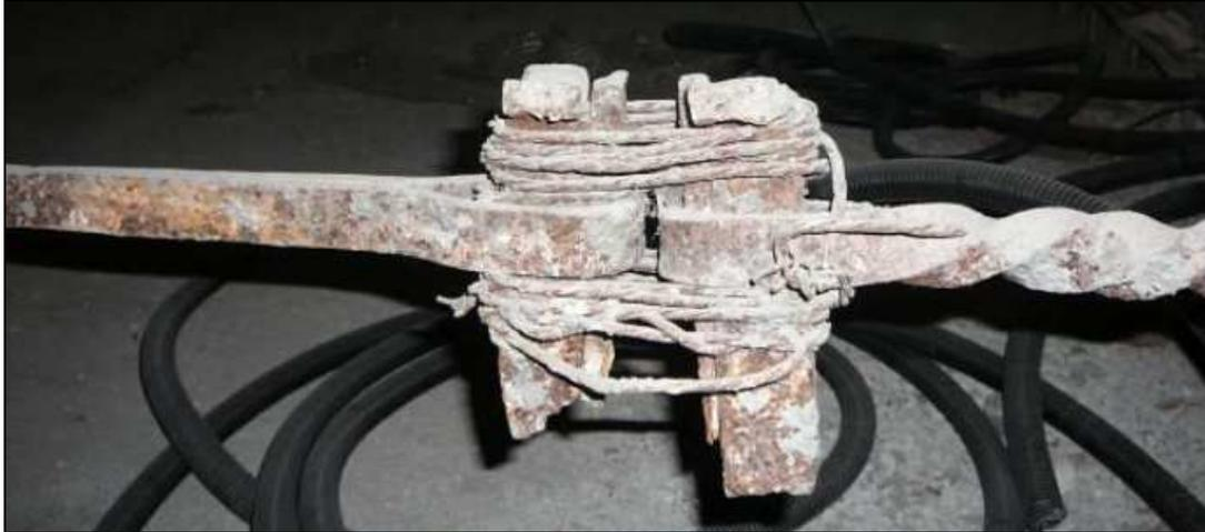
**Figura 38:** Connessione di due tratti di una medesima catena.
