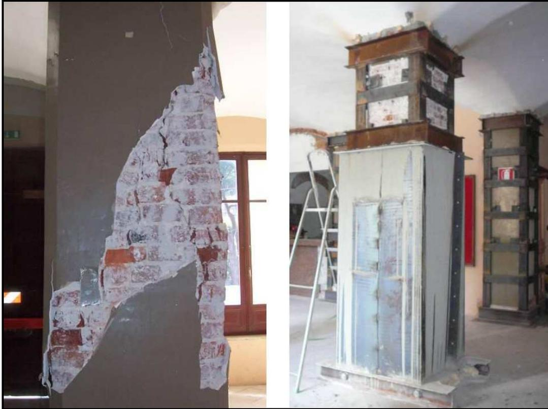
**Figura 40:** Pilastro in muratura ritrovato collassato la mattina del 25 giugno 2008
