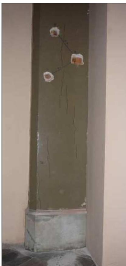
**Figura 42:** Pilastro con profonde lesioni verticali
