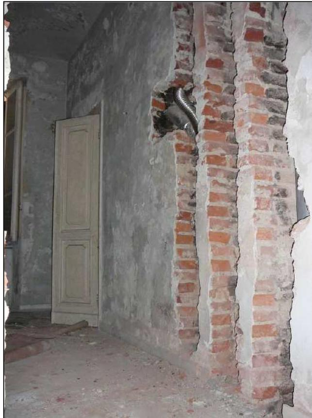
**Figura 39:** Crene per impianti nelle pareti di spina dell'edificio.
