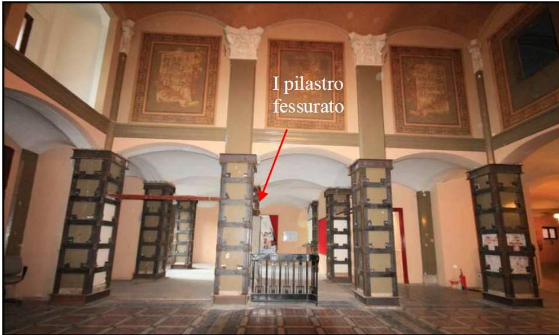
**Figura 43:** Pilastri del foyer consolidati con cerchiature metalliche
