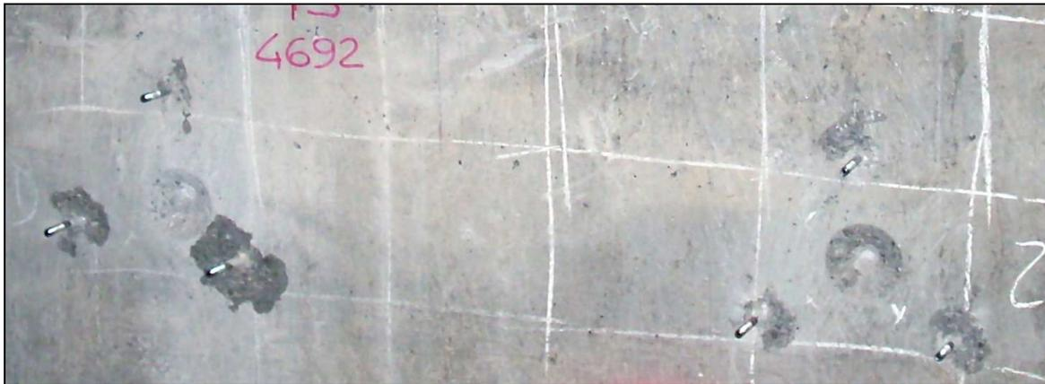
Figura 31. Dettaglio delle prove di *pull out* e delle prove con sonde *Windsor*.
