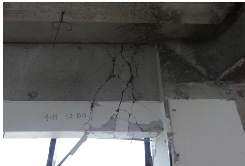
Cerniere plastiche in travi (fusibili sacrificali)
