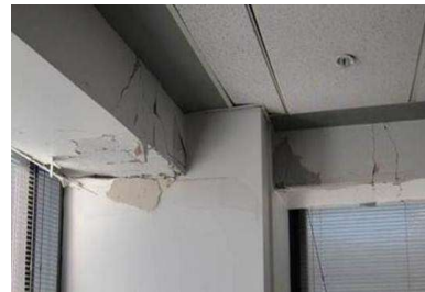
Cerniere plastiche in travi (fusibili sacrificali)
