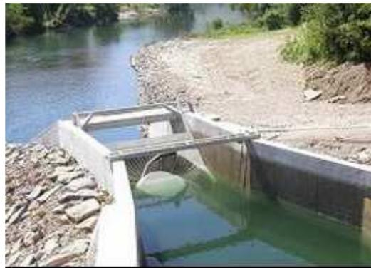
*Fig. 2.7 - VLH turbine (VLH turbines, MJ2 Technologies S.A.R.L.).*
